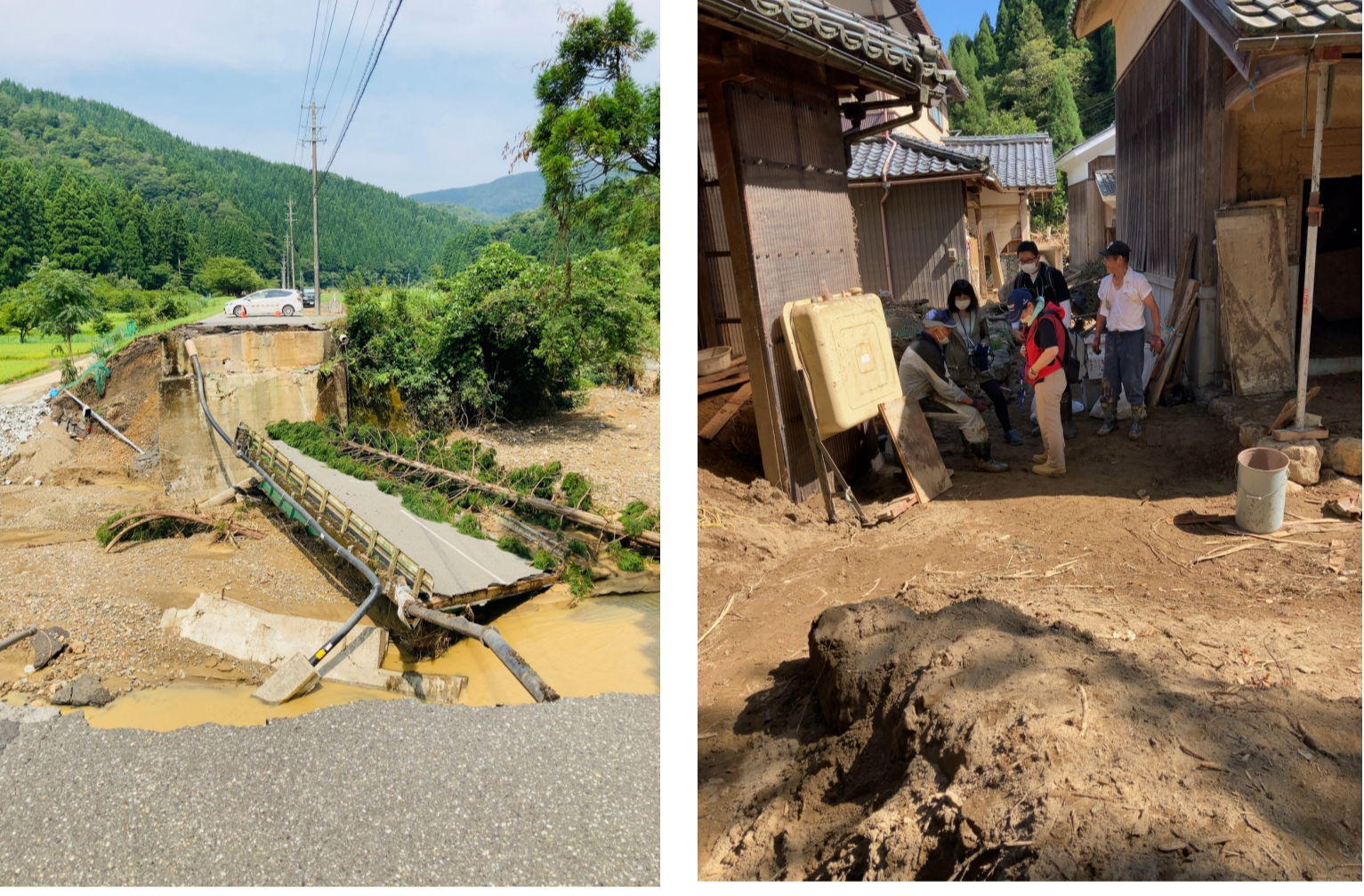
写真1 崩落した道路 写真2 巡回の様子
