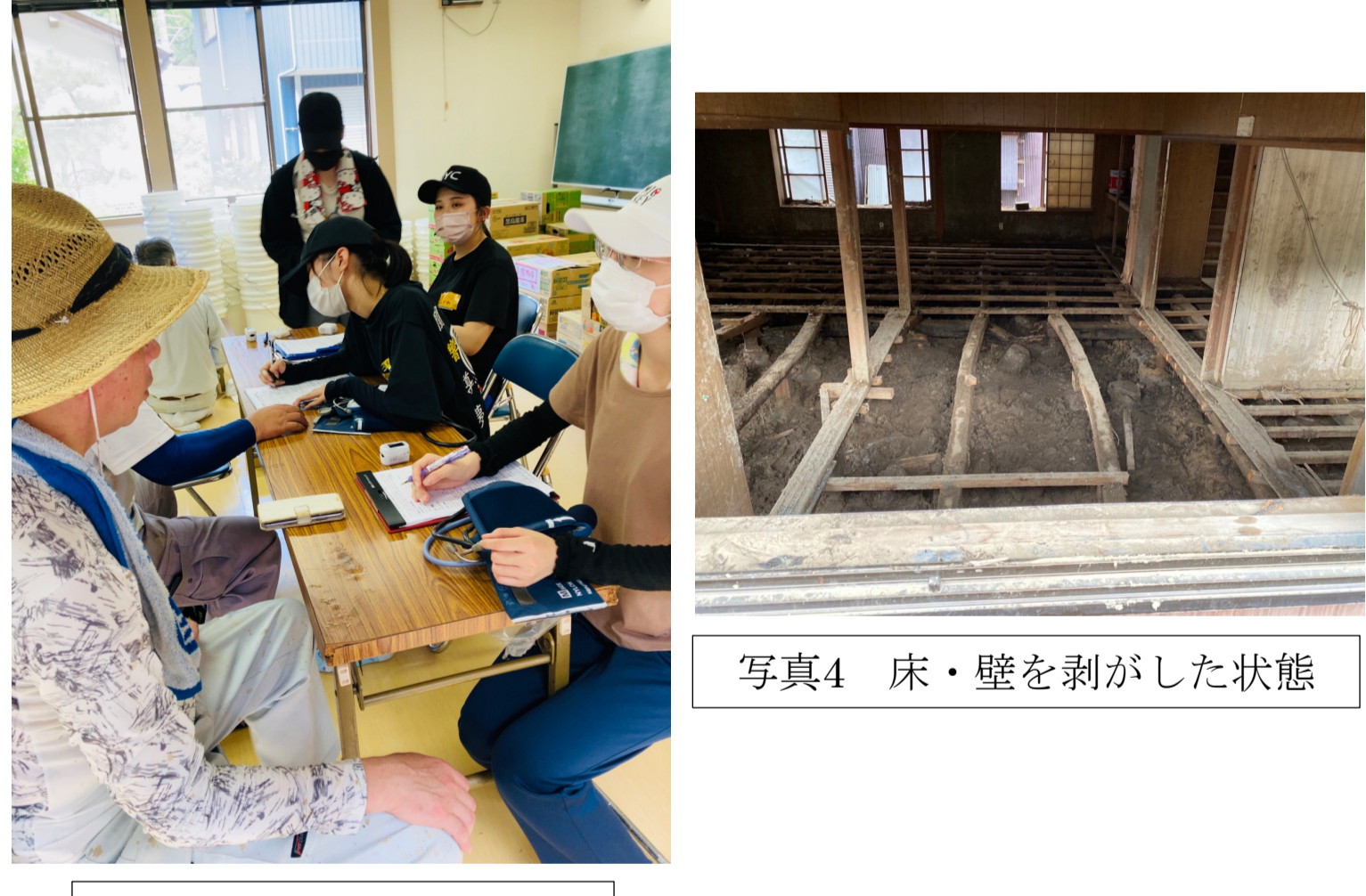
写真3 健康観察の様子 写真4 床・壁を剥がした状態
